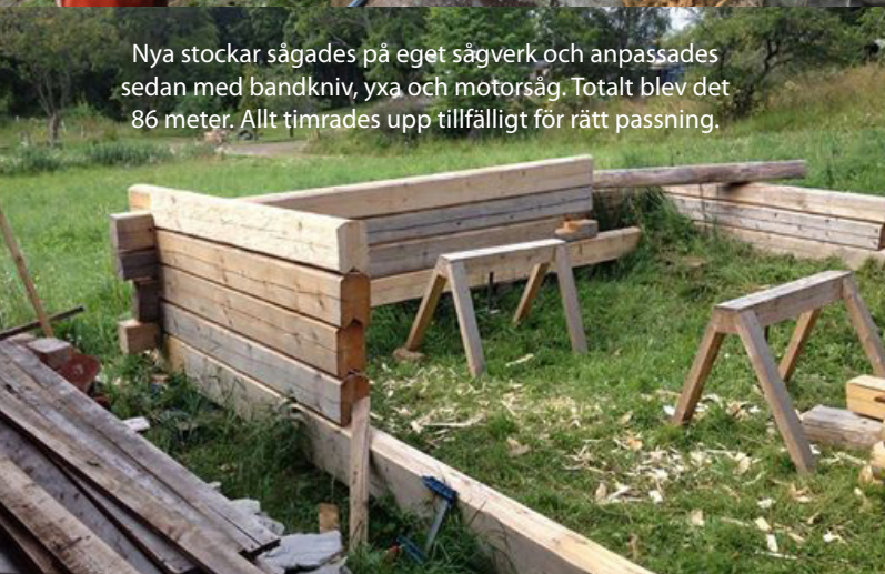
Havvägs med uppbyggnaden. Stockarna fixeras med fastskruvade brädor samt limknektar. Det är inte helt lätt att timra uppifrån och ner.
